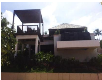
O/V VILLASの外観
